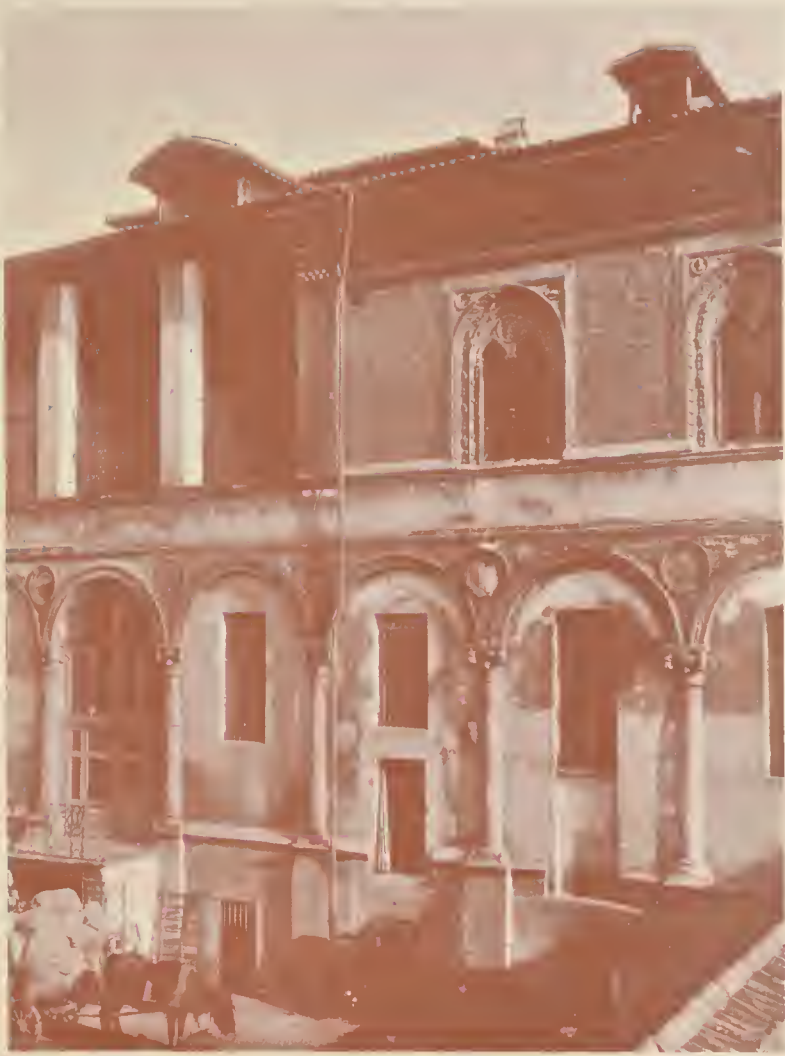
Fig. 108 — Milano, Ospedale Maggiore. Lato esterno verso San Nazaro
